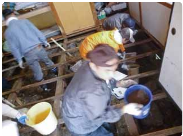
床下浸水の被害を受けた家屋の土砂の除去、家財の移動をお手伝いしました
